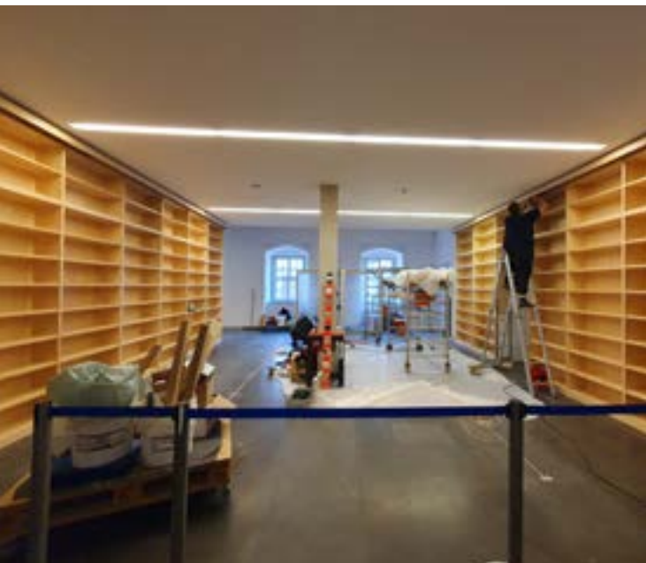
Neue Flächen im Studienzentrum: Bauarbeiten für die Leselounge
