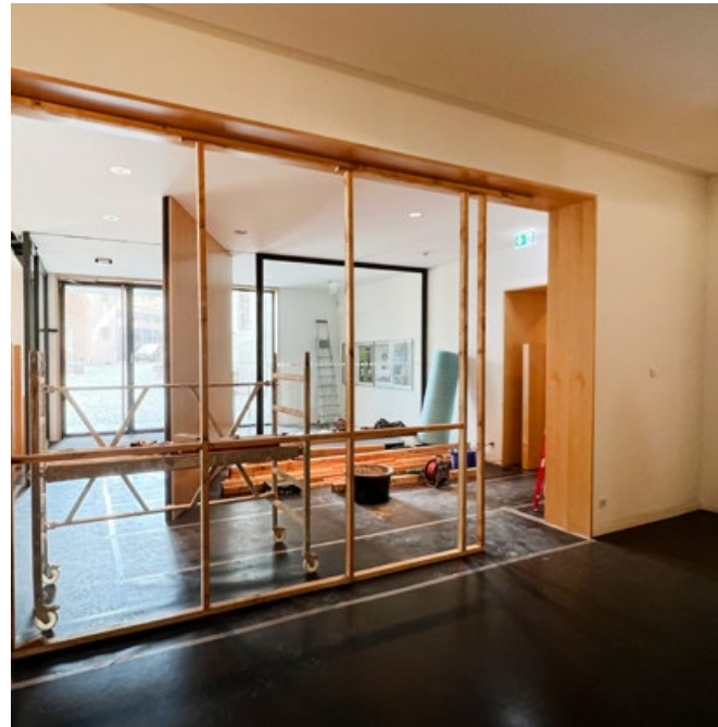
Bauarbeiten im Foyerbereich des Studienzentrums
